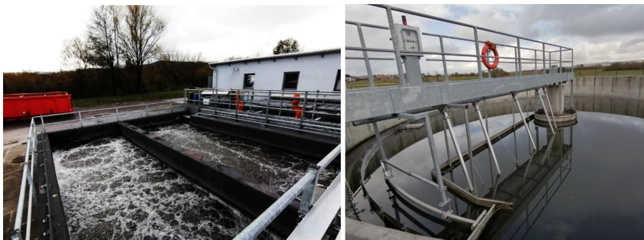
Slika 1: Objekti na KČN Ig: biološki bazeni (levo) in usedalnik z očiščeno vodo (desno).
